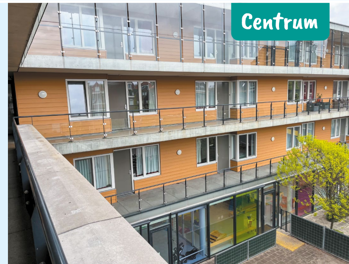
Het gebouw aan de Gedempte Biersloot na de opknappbeurt.
